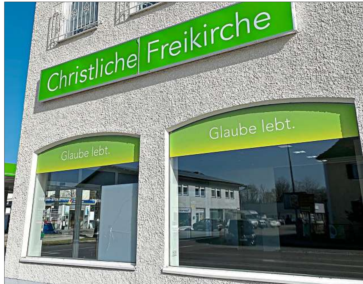
Das Erdgeschoss ist bereits leer, die Freikirche ist ausgezogen. Bald startet der Intensivpflegedienst mit den Umbauarbeiten und vergrößert sich.
