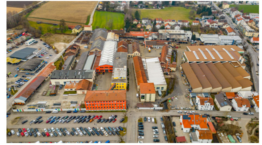
Aktuelle Ansicht der Fa. EWD (Esterer, Wurster und Dietz GmbH)
